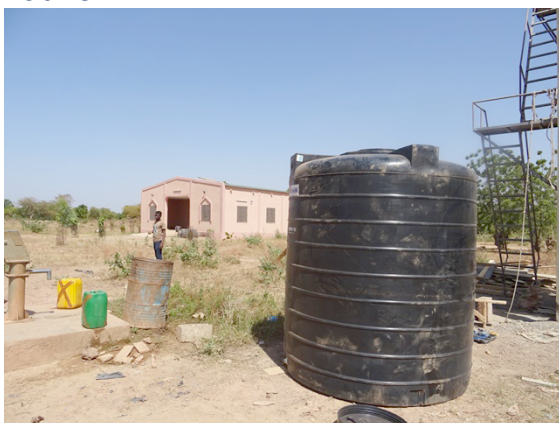
Fertig: Gesundheitszentrum mit Brunnen u. Wasserreservoir
