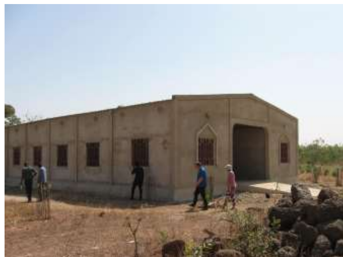
Der Rohbau der Krankenstation in Wapassi
